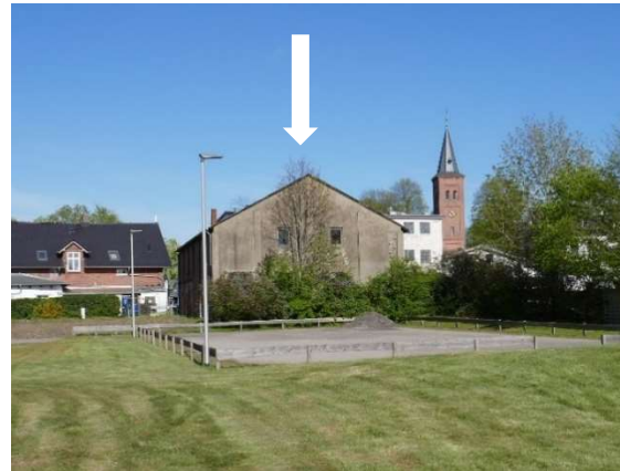
Ahornbaum St \varnothing 0,25 am Gebäude Kieler Str. 93a
