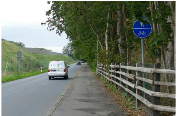
Fahrbahnbreite 6,00 m; gemeinsamer Geh-/ Radweg (für beide Richtungen; Breite 2,50m)
