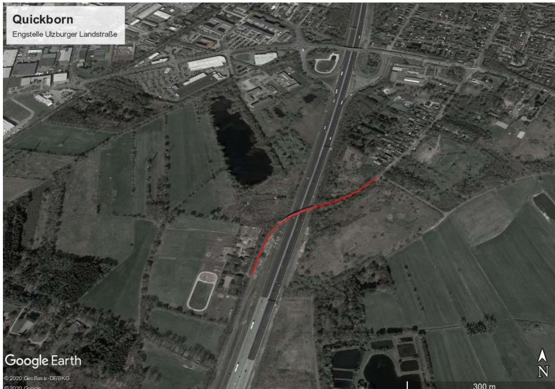
Fahrbahneinengung 5,00m auf 450m Länge (170m lange Abschnitte beidseits des 110m langen Brückenbauwerks)
