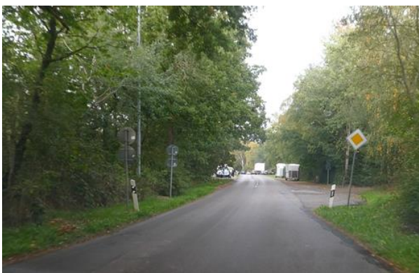
Kurz vor der Einmündung des Breedenmoorweges beträgt die Fahrbahnbreite 6,50m
