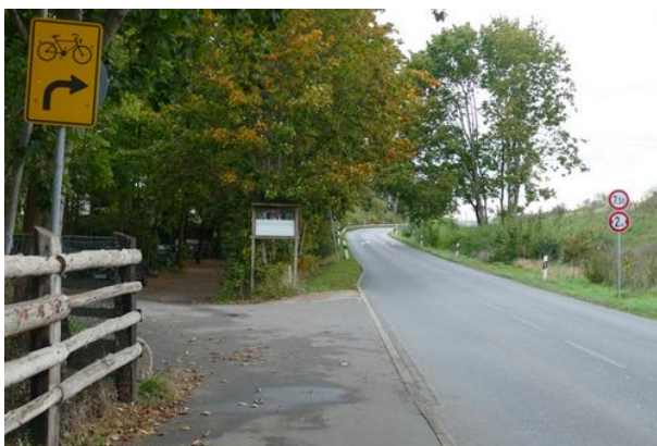
Umleitungsbeschilderung Radfahrer am Ende des gemeinsamen Geh-/Radweges
