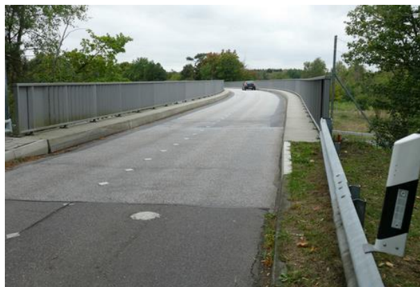
Beginn der Autobahnbrücke (70 cm breite Kappen notfalls von Fußgängern nutzbar)
