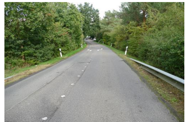
Allmähliche Aufweitung der Fahrbahn auf 6,50m
