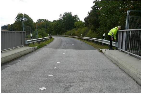
Brückenbauwerk / Rampe mit Schutzplanken
