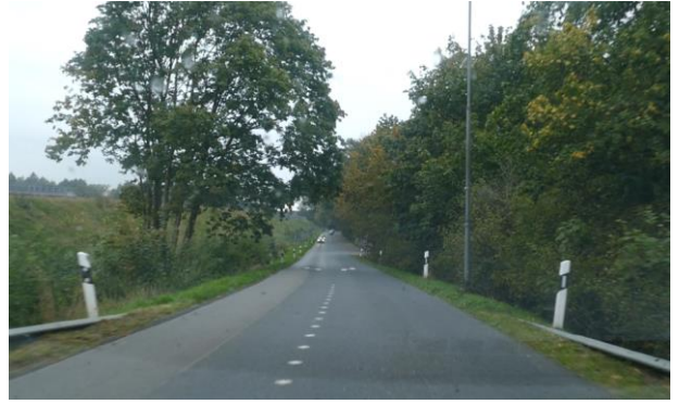
Andeutung einer Leitlinie im Engstellenbereich
