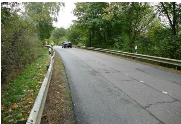
Fußverkehr auf 50 cm breitem Streifen zwischen Schutzplanke und verengter Fahrbahn
