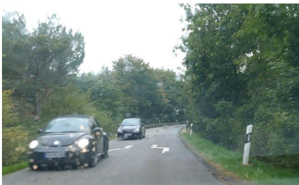
Fahrbahnverengung auf ca. 5,00m
