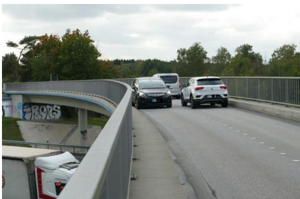
Fahrbahnbreite zwischen den Kappen 5,00m
