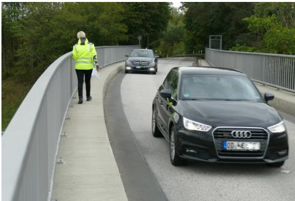
Fußverkehr auf 70cm breiter Brückenkappe
