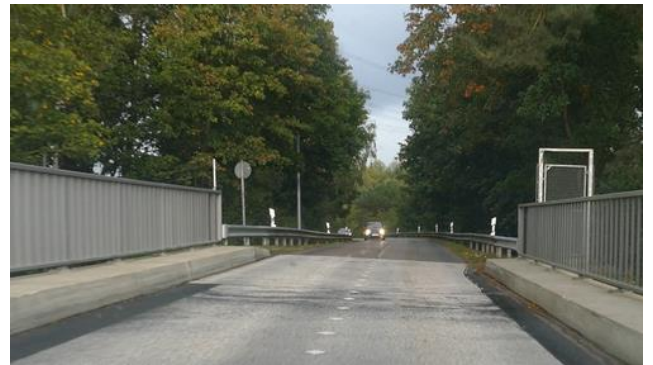
Übergang vom Brückenbauwerk zum Gefälle der Rampe
