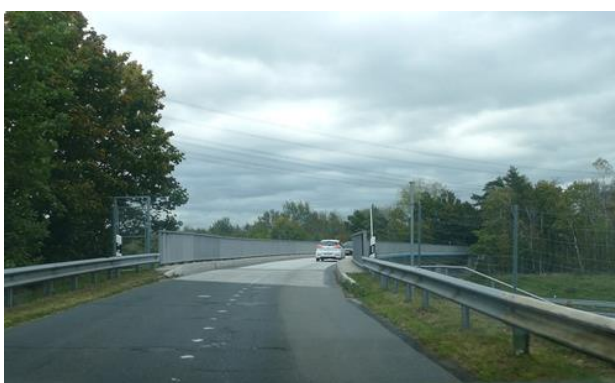
Rampe mit Schutzplanken / Brückenbauwerk
