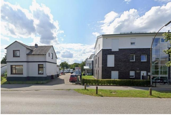
Ansicht von der Kieler Straße mit nördlich angrenzenden neuen Wohngebäuden (rechts)
