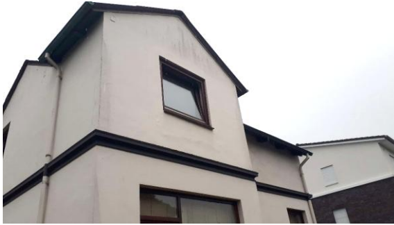
Fassade des Gebäudes Kieler Straße Nr. 51
